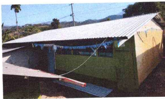
Foto 2: Sustitución de lámina, por lamina troquelada aluzinc calibre 26 en 2 aulas
