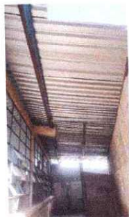
Foto 1: Sustitución de lámina, por lámina troquelada aluzinc calibre 26 en bodega.
